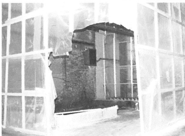
Rivning av vatskrubber ger plats åt ny härdningsugn för skiftnycklar.
