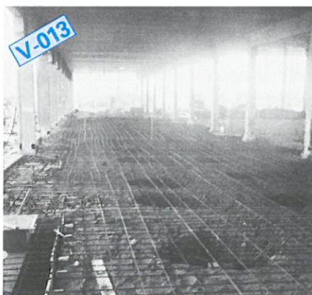
I verkstadsdelen fortsätter finjustering av golvet för armering och golvläggning.
