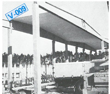
Resning av betongstomme och betongbalk. Läggning av ytongtak påbörjas vecka 10. Uppsättning trästomme och resning trätakstolar i lågdelen pågår.
