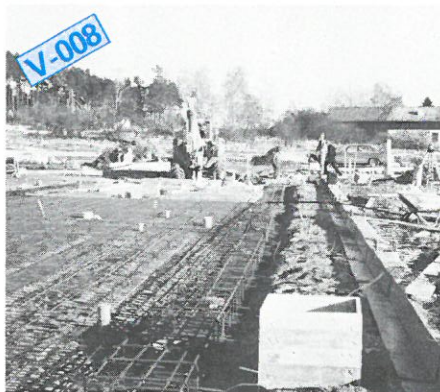
Inläggning av avlopp i lågdelen är klart. Formgivning linje A är klar. Upprensning av verkstadsdelen är nästan klar. Återfyllnad och finjustering över lagda rör samt armering och gjutning av lågdelen avslutas i mitten av veckan.
