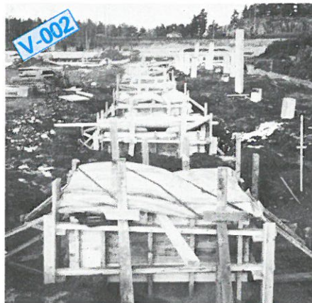
Formsättning för pelare och linjerna C och 2 är utförda.
