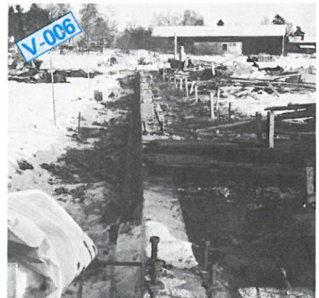
Linje 2 är färdiggjuten. Pelarraden och samtliga plintar är gjutna och klara för montering av förtillverkad stomme.
