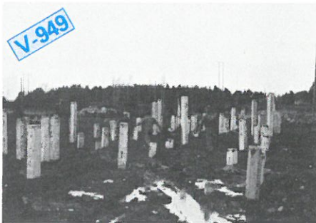
Pålningarbetet är påbörjat. 300 pålar är ner-slagna och ytterligare 100 skall slås ner.
