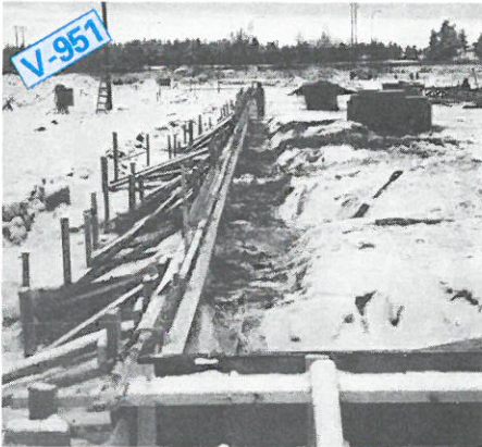
Uppgrusningen av dräneringsgruslagret är inte helt färdigt. Formsättning av en gavel och en långsida är klar för armering.
