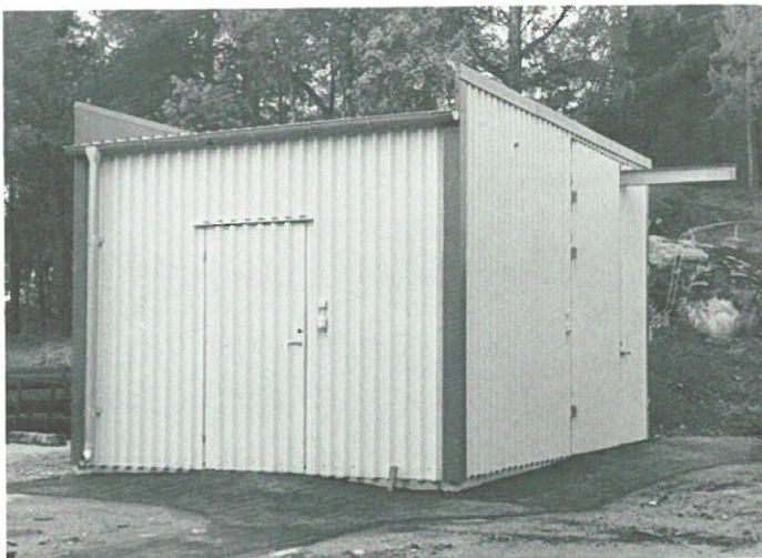
Nytt förråd för gasflaskor beläget på smedjans baksida.
