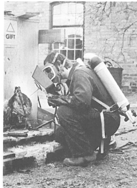
Björn Stålbörn svetsar igen en läckande giftbehållare, varvid livsfarlig cyanvätegas kan bildas.
