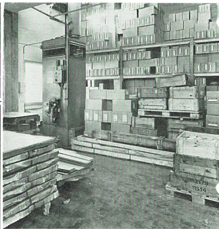
Det fristående Thermobloc-aggregatet för monteringshallen skymtar i bakgrunden. Aggregatet är försett med uteluftsintag och blandningsspjäll.
