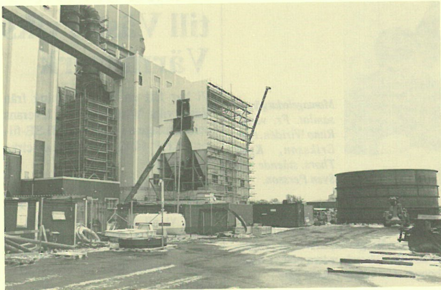
Västeråsmontaget, fotograferat den 28 februari. I mitten syns slangfiltret under pågående beklädnadsarbete. Filtrets övre kant är 36 m över marknivå. Till höger i bild pågår tillverkning av reaktorn, som har 13 meters diameter.
