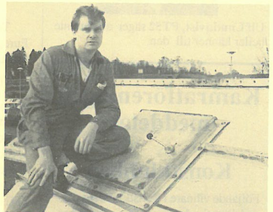
Lars-Göran Pettersson intill en inspektionslucka som på de flesta konstruktioner i fortsättningen kommer att svetsas fast. (På bilden är luckan skruvad mot kanalplåten.)
