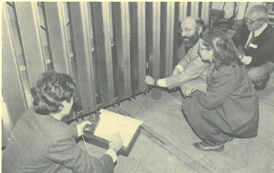
Här mäter Sonsino, Martet Mercier luftflödet genom luftspredaren, medan Donnars, IBM skriver protokoll, Sontag, konsult och Lena Sterner, säljare Fläkt, följer intresserat mätningen.
