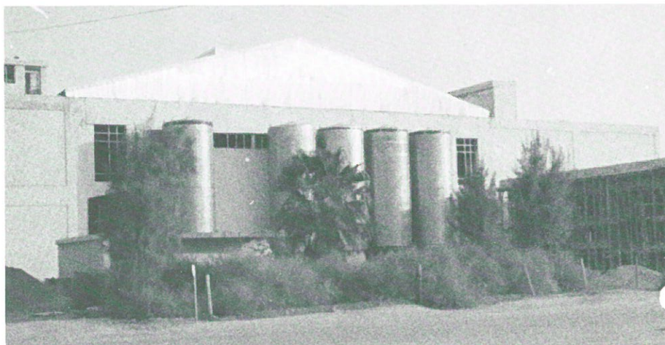
Gaveln till mejeribygget i Abu-Ghuraib med intagstankarna rymmande 300.000 l.
