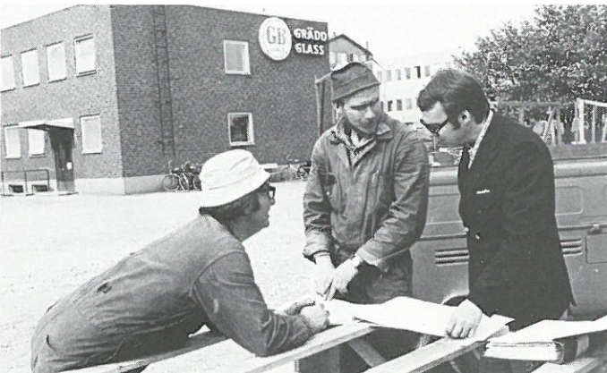
Ture Uppman och Håkan Eriksson från Bröderna Uppmans Plåt och Roland Sundqvist löser problem i en arbetsbeskrivning till Gävle Mejeris tillbyggnad.
