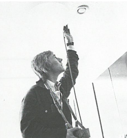
Håkan Thorsling, service, mäter en frånluftsväntil i Andersberg.
