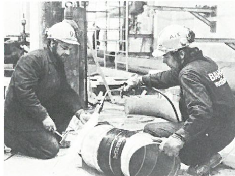
Roger Mårtensson och Bengt Thorell kommer från Malmö. Här tätar de kanalskarvar med krympande plastfilm.
