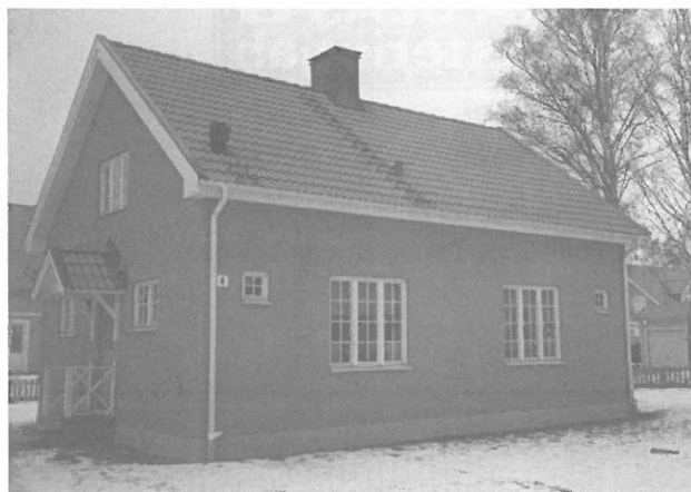
Visar villa med 2 lägenheter om 2 rum och kök. Ett av rummen var ett vindsrum. Matkällare med ingång utifrån fanns under varje lägenhet.
