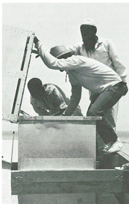
Montering av takfläkt och takstos
