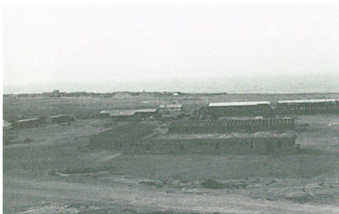
En av anläggningarna under uppförande
