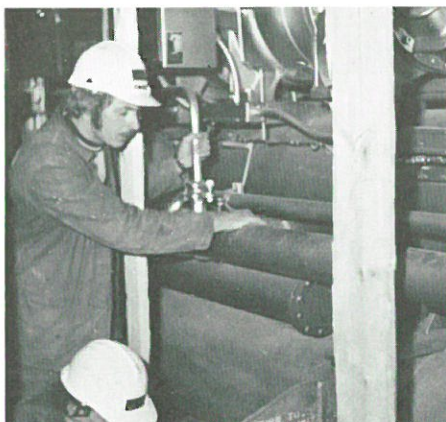
Inmontering av kylaggregat
