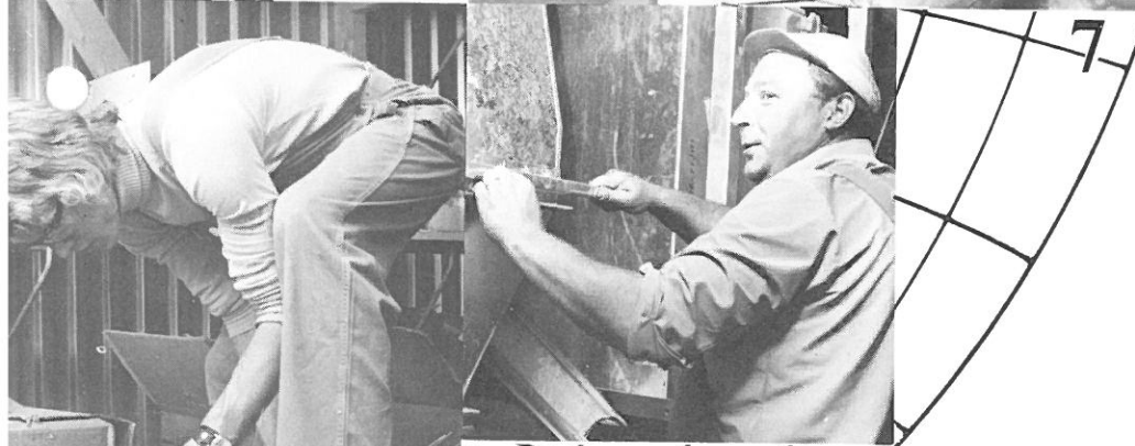
Bild 5 Montör Bo Christoffersson bilden håller på att »sätta galler» i en takhuv på kv Vevaxeln i Ystad.
