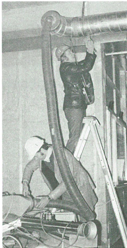
Provtryckning . . . Askelöf och Ekblom
