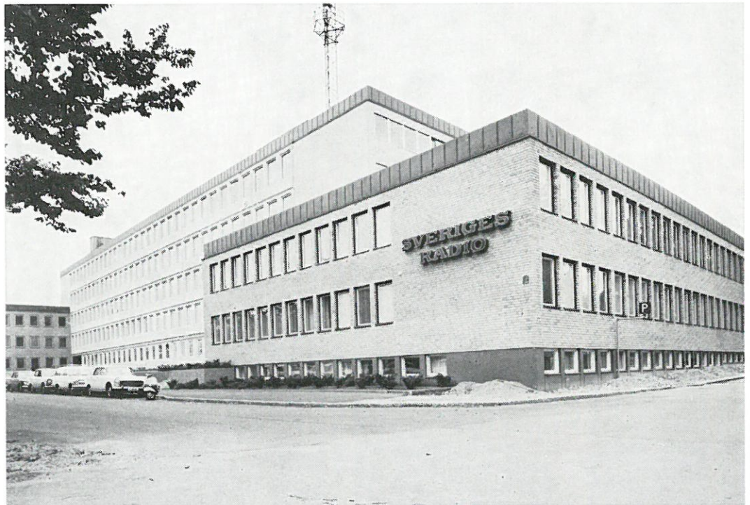
Kv. Ansgarius, Växjö Kontorsbyggnad, som bland annat inrymmer lokaler för Sveriges Radio. Även Bahco-filialen i Växjö har lokaler i samma fastighet. Luft från kontoren utnyttjas som ersättningsluft i garagelokalerna i källaren.
