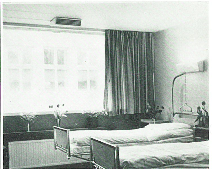
Interiör från vårdrum med lufttillförsel genom Bahco takventil RGV. En ventil är i allmänhet tillräcklig för vårdrum med upp till tre patienter.
