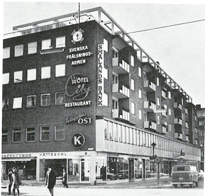
Svenska Frälsningsarmén, Jönköping. Kyrka, hotell med restaurang, butiker, bostäder. Vent. konstr.: Bahco, Norrköping. Arkitekt: Hans Ancker Holst, Stockholm.
