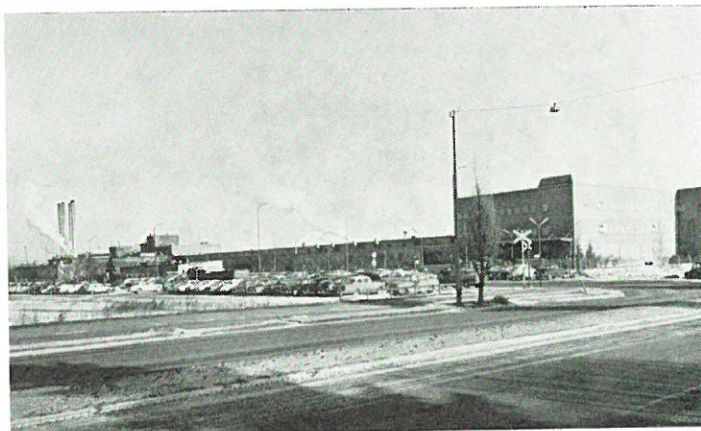
Goodyear Gummi Fabriks AB, Norrköping. Har praktiskt taget allt ifråga om ventilationsutrustning installerat, bland annat slangfilter för kimrök. Vent.konstr.: Bahco, Norrköping.
