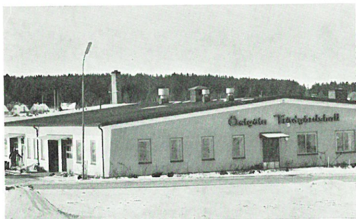
Östgöta Trädgårdshall, Linköping. Distributionsanläggning för blommor, frukt och grönsaker. Vent.konstr.: Bahco, Norrköping. Arkitekt: Bror Wincrantz.
